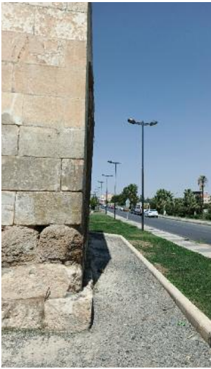
■ Altta üç sıra sur taşları, üzerinde sonradan ilave edilen taş duvar.
