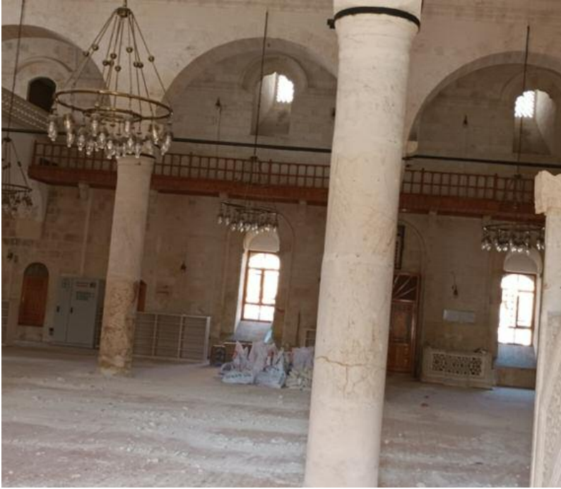
■ Görsel 1b: Yapı İçerisinden Görünüm
