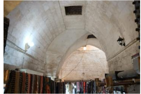
■ Görsel 7b: Beşik Tonozlu Üst Yapı
