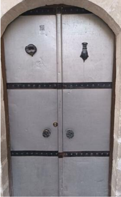
■ Görsel 19a: Kapı Kanatlarında Tokmaklar Bulunan Örnek
