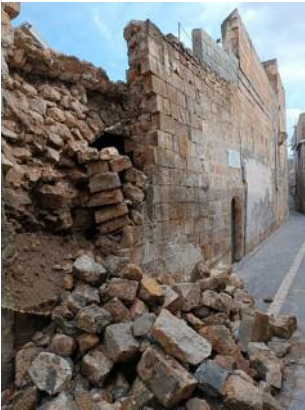
■ Görsel 18a: Duvarları Sokağa Yıkılan Ev (1)
