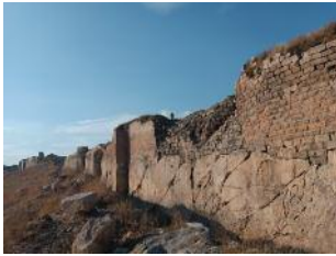
■ Görsel 9b: Yapının Arka Kısmı ve Surlar
