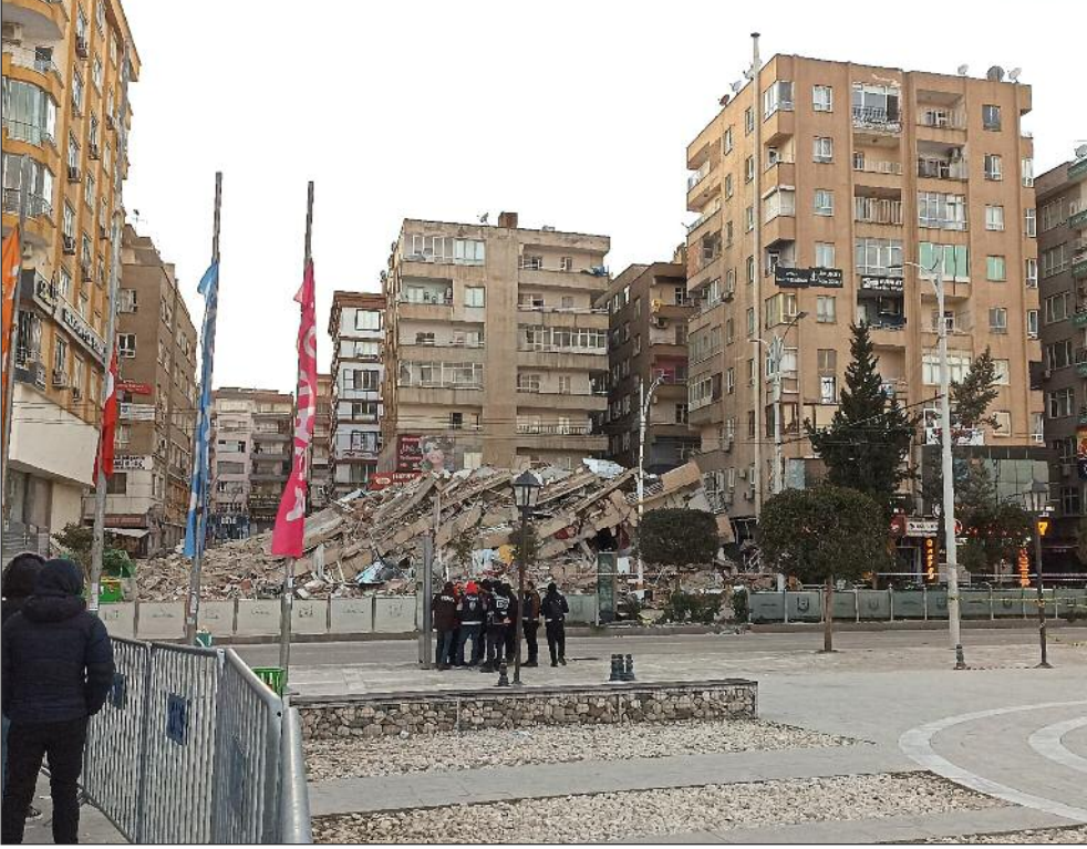
■ 6 Şubat 2023 - Şanlıurfa Atatürk Bulvarı'nda deprem nedeniyle yıkılan bir bina. (Foto: İbrahim Halil Şeker)
