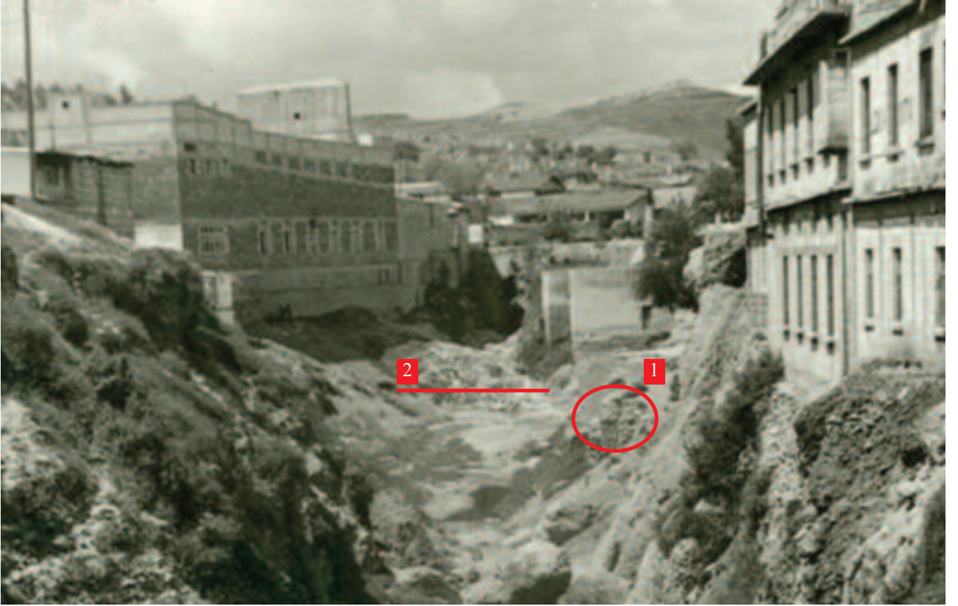
■ Karakoyun Deresi üzerine kurulu değirmenlerden birinin mevkisi. 1-Değirmen binası. 2-Suyun önüne bent yapılarak yükseltilip, değirmen çarkına akıtıldığı nokta.
