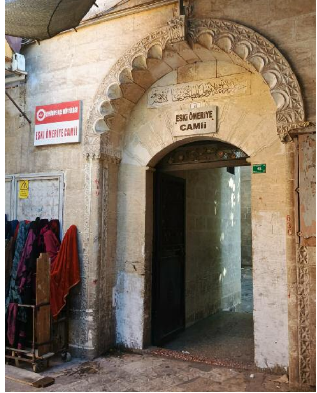
■ Eski Ömeriye Camii (Kazancı Camii) girişi.
