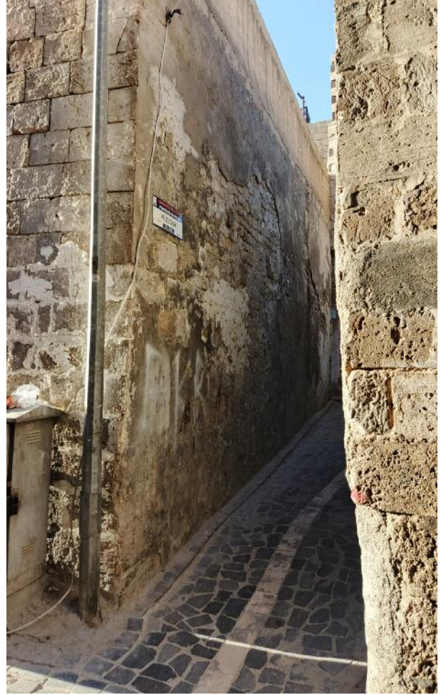
■ Urfa’da nüfuzu ile bilinen Firuz Bey’in adını taşıyan, ancak yazım hatalarıyla günümüzde Prüz Sokak olarak anılan Pınarbaşı Mahallesi ile Türk Meydanı Mahallesi’ni ayıran Harun Bey Yokuşu.
