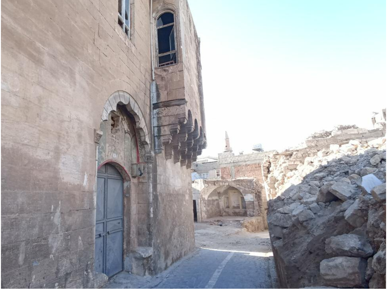
■ 6 Şubat 2023 depremlerinden sonra Firuz Sokak (Foto: İbrahim Halil Şeker)
