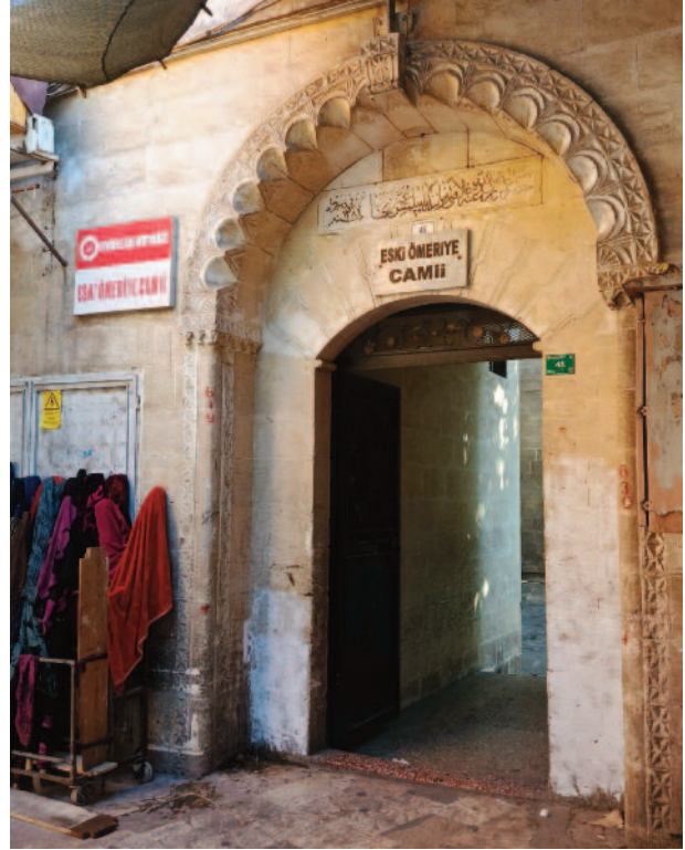
■ Eski Ömeriye Camii (Kazancı Camii) girişi.
