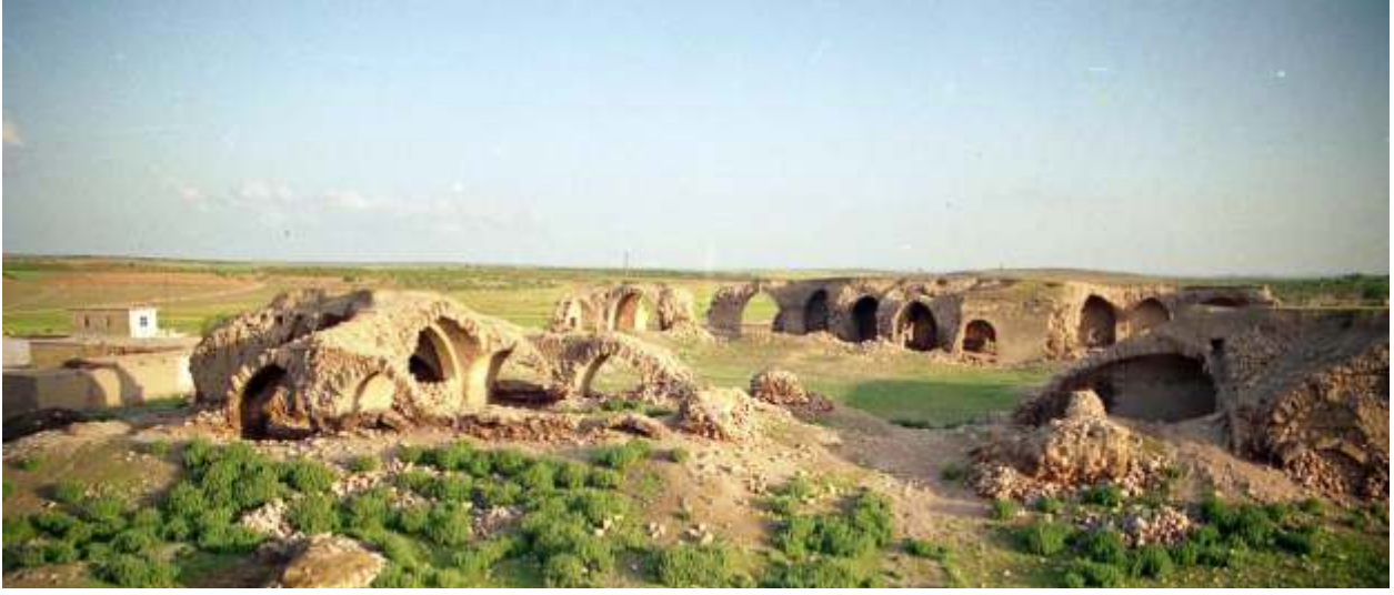
Restore edilmeden önceki haliyle Çarmelik Derbendi (Kervansaray) / Foto: A. Cihat Kürkçüoğlu
