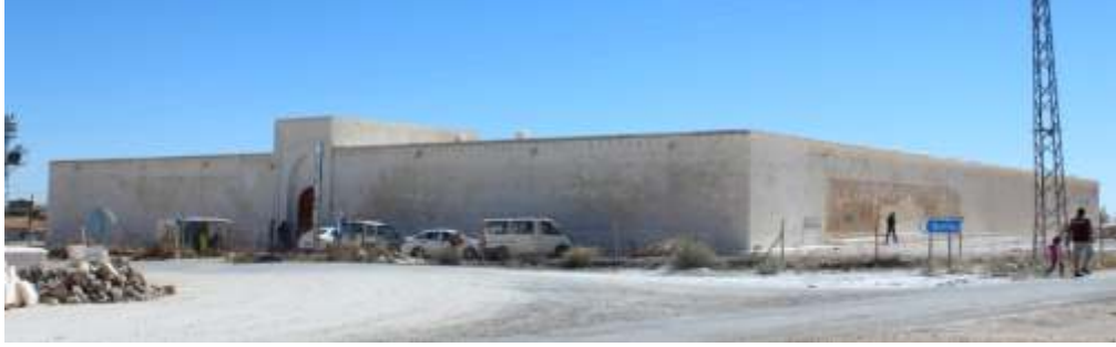
2016 yılında yapılan restorasyon sonrası dıştan görünüm / Foto: Işıl Palalıoğlu
